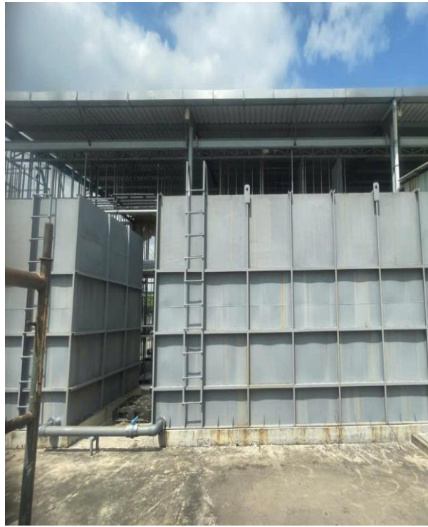
Bể thu gom, xử lý sơ bộ nước thải sản xuất bằng Thép TC3 + sơn phủ Epoxy
