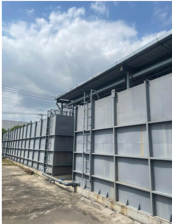
Bể thu gom, xử lý sơ bộ nước thải sản xuất bằng Thép TC3 + sơn phủ Epoxy
