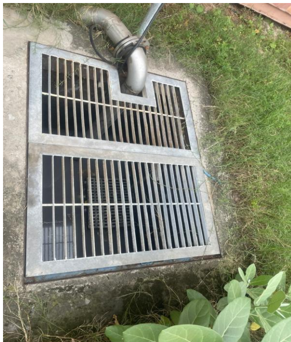
Bể trung hòa nước thải
